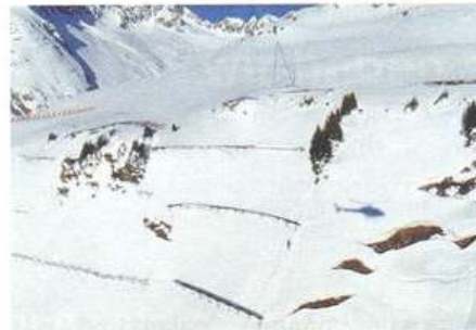
Lawinerverbauung L'Ondadusa, verbaute und noch nicht verbaute Fläche mit Anrissansätzen, Tujetsch, 12. Januar 2012.
